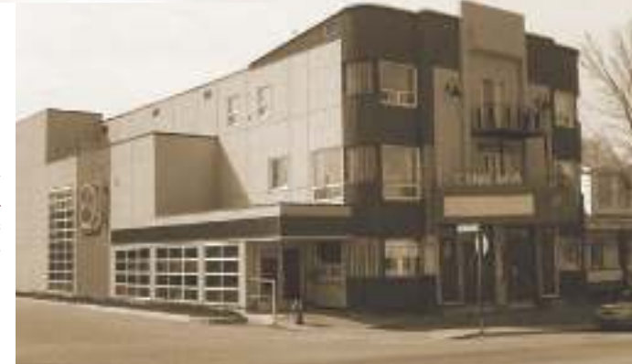
Le Théâtre du Rift complètement rénové Source : Sylvain Marcotte
