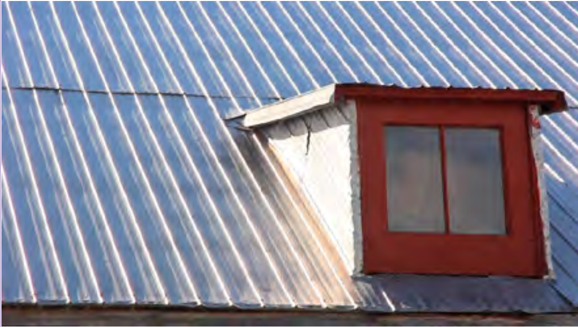
// Lucarne sur la pente du toit
