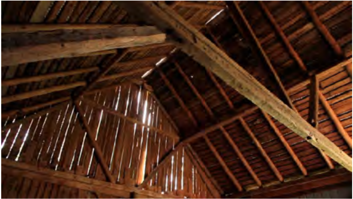
// Charpente du comble triangulaire
