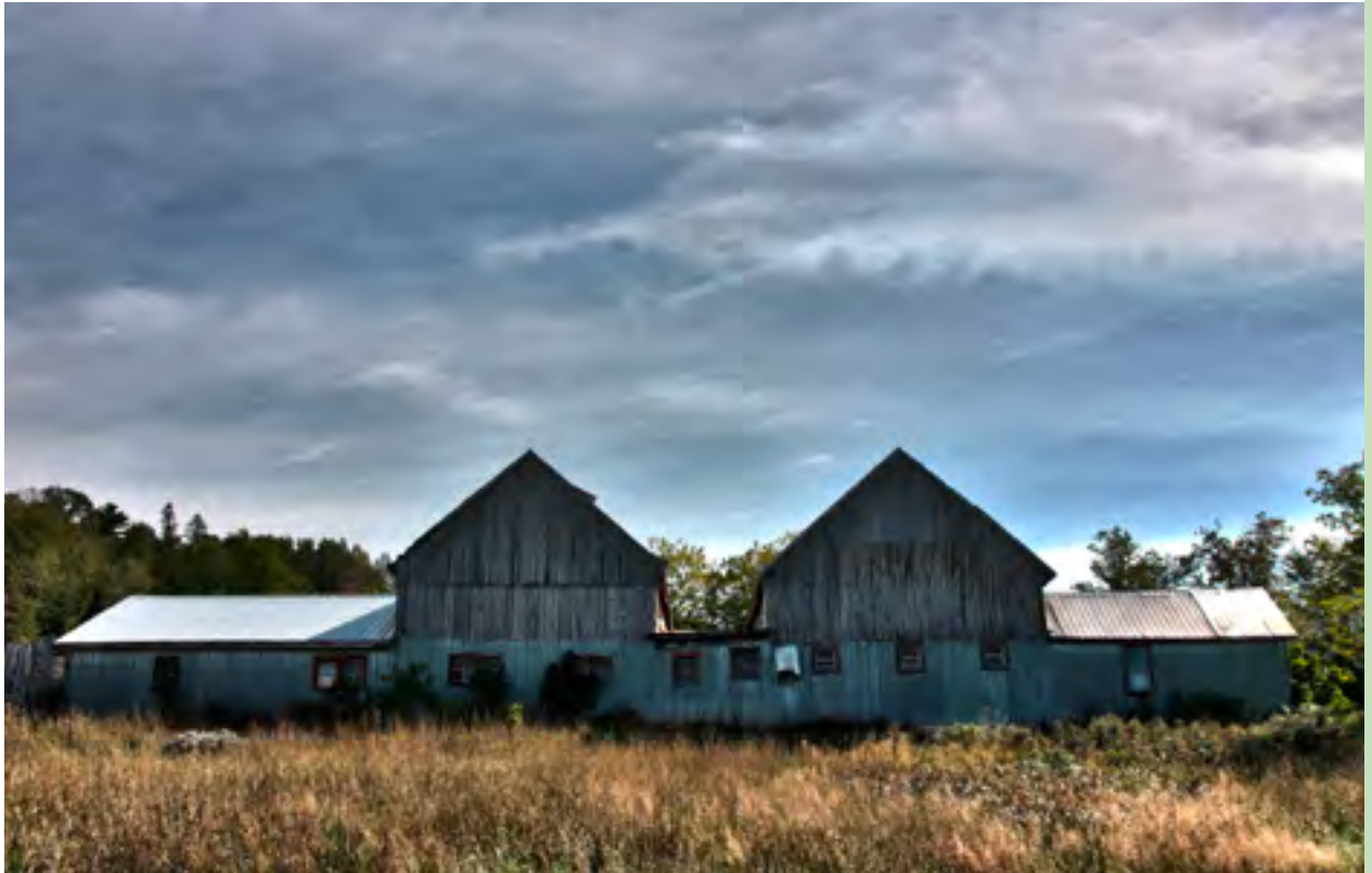
// Façade Ouest des granges doubles
