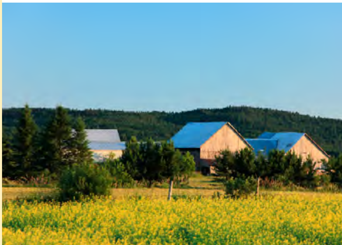
40 Adresse // 719 Chemin des 6 e et 7 e rang Nord, Lorrainville QC Propriétaire // Ferme chez Lyne et Sylvain S.E.N.C. Granges à combles triangulaires
