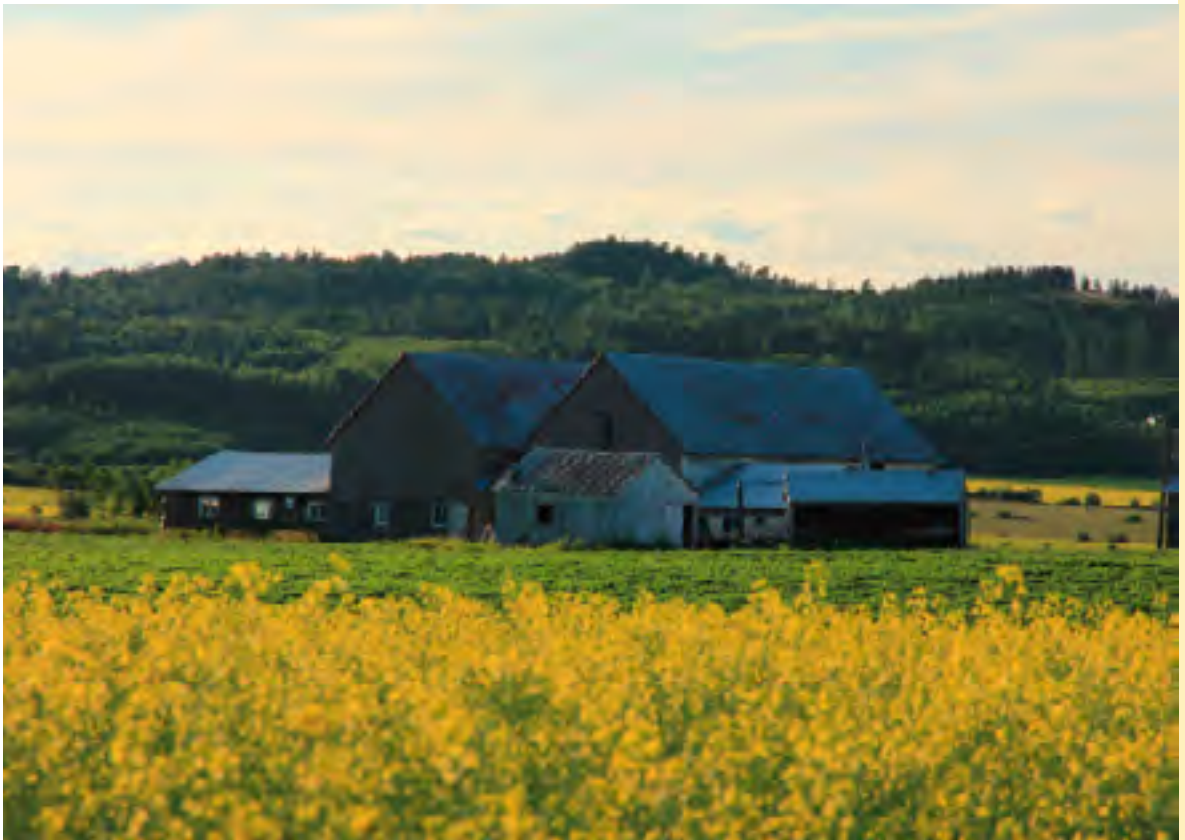
49 Adresse // 919 Chemin des 5 e et 6 e rang, Lorrainville, QC Propriétaire // Ferme Baril Bon Lait Granges à combles triangulaires
