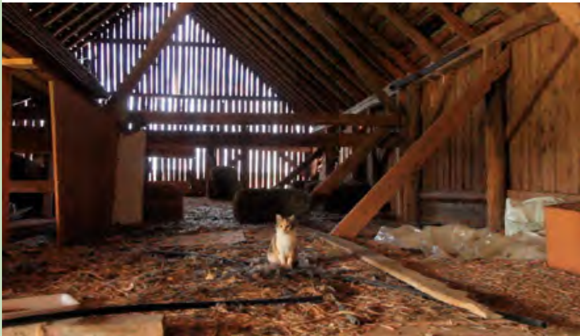
// Différents occupants se sont appropriés les lieux
