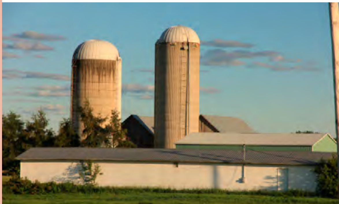
81 Adresse // 385 Route 391 Sud, St-Eugène-de-Guigues, QC Propriétaire // Lorraine Falardeau Granges à combles triangulaire et français
