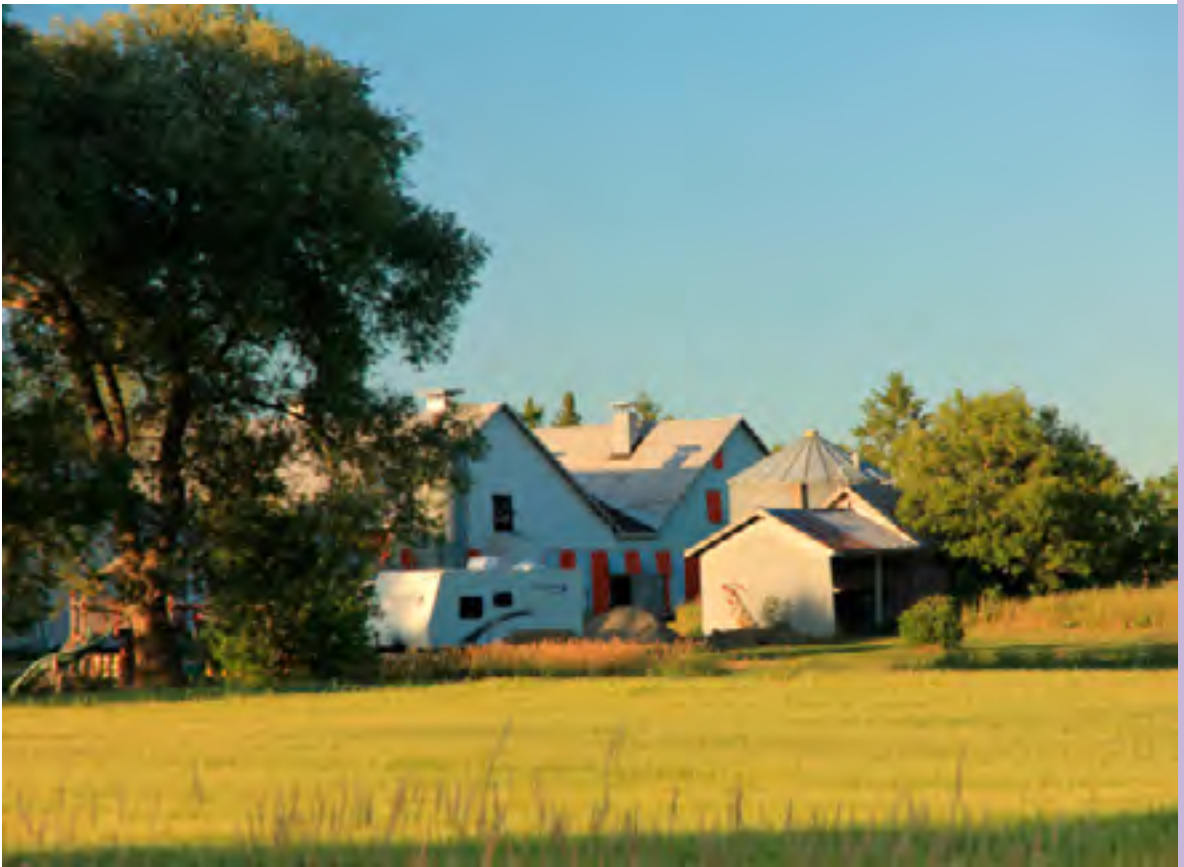
18 Adresse // 657 8 e et 9 e rang de Guigues, Laverlochère, QC Propriétaire // Ferme Jopicher Granges à combles triangulaires
