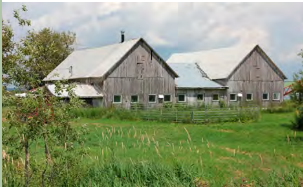
68 Adresse // Chemin du 2 e et 3 e rang, St-Bruno-de-Guigues, QC Propriétaire // Olivier Dunand Granges à combles triangulaires
