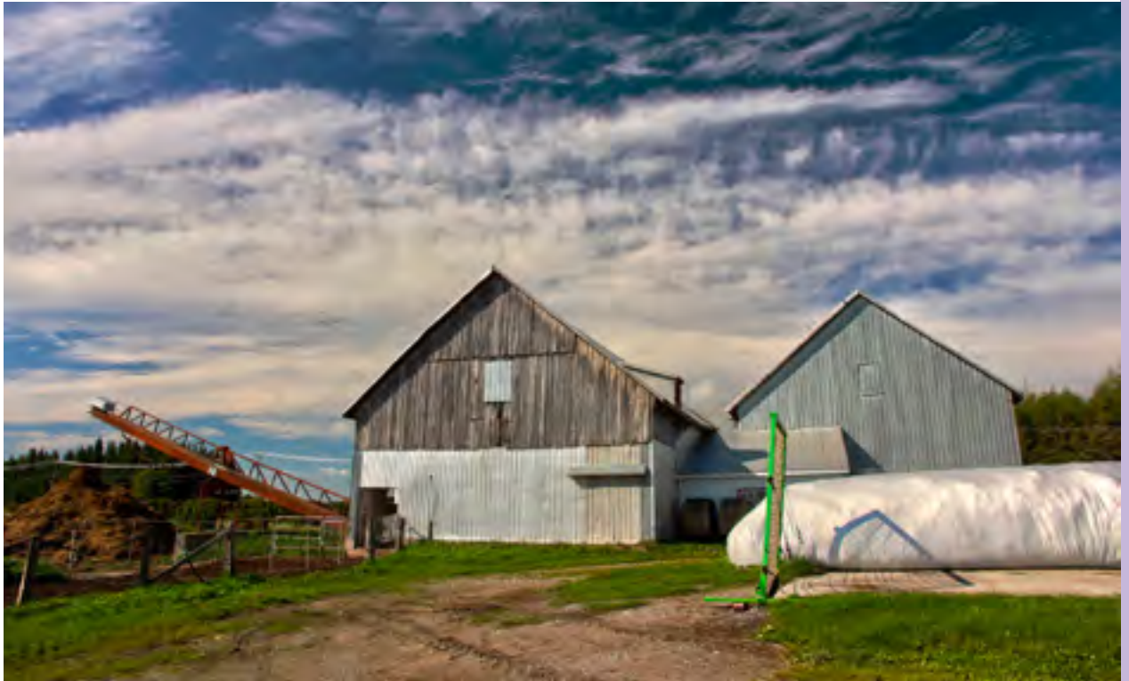
// Vue arrière des granges (côté Est)
