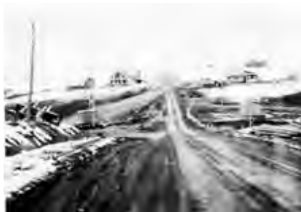
// FCB2-3-1 AB, Vue générale de Béarn vue du chemin allant vers Béarn.
