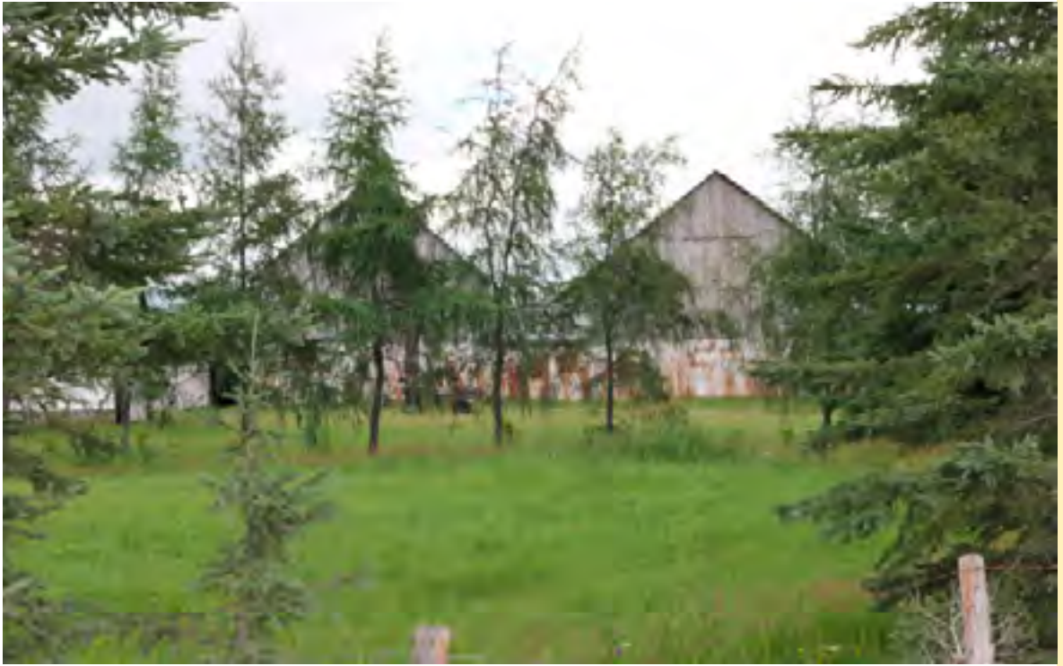
45 Adresse // 653 Chemin des 2 e et 3 e rang Nord, Lorrainville, QC Propriétaire // Alain Boucher Granges à combles triangulaires
