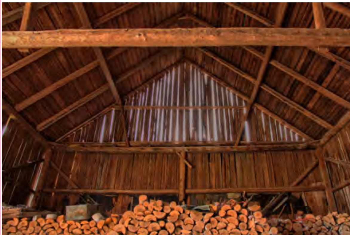
// Grange côté Nord (1912) extrémité Est
