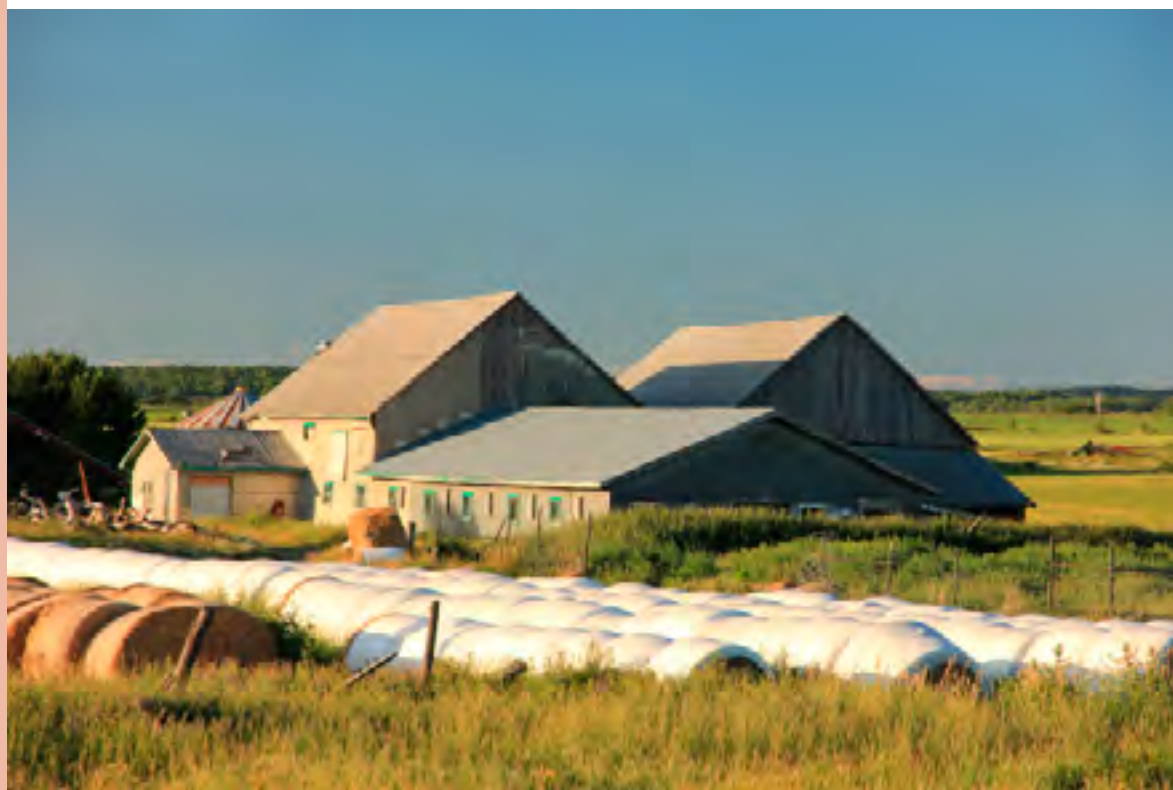
82 Adresse // 376 Route 391 Sud, St-Eugène-de-Guigues, QC Propriétaires // Pascal Bruneau et Marie-Hélène Nolet Granges à combles triangulaires
