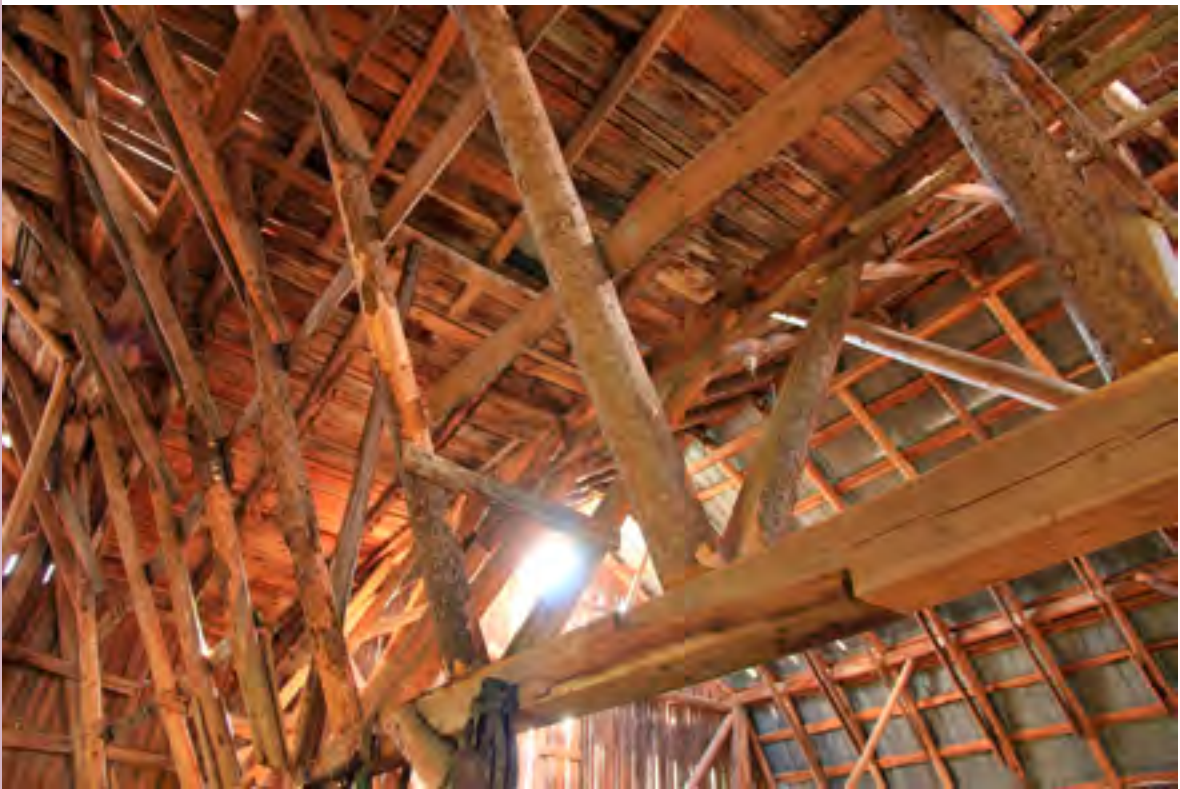
// Structure entre les deux toits
