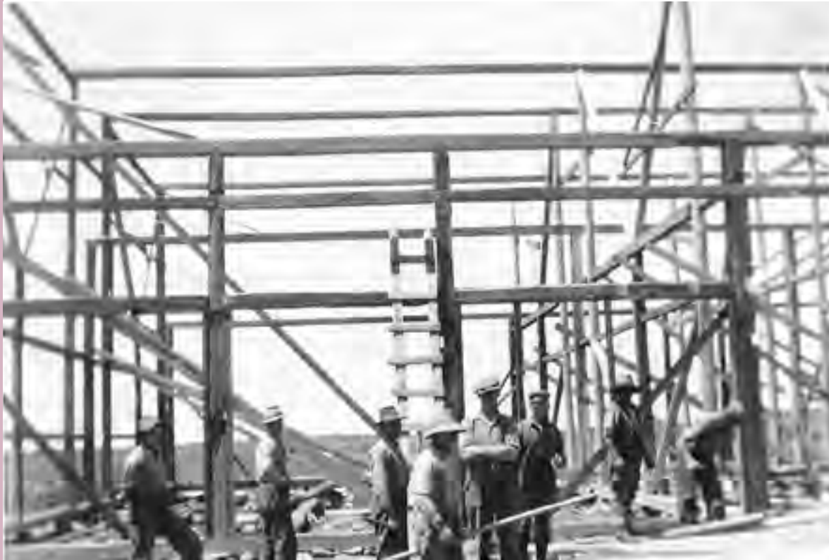
// Reconstruction des granges doubles en 1942
