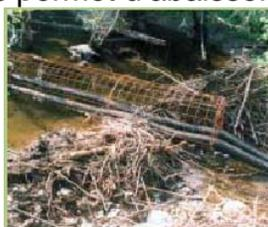
Ces dispositifs permettent d'abaisser le niveau de l'eau à un degré acceptable, tout en laissant en place le barrage. Deux dispositifs sont proposés:
