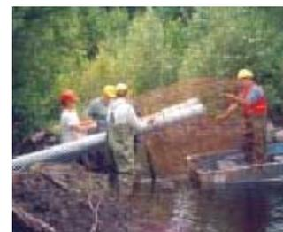
Tuyau coudé : dispositif constitué d'un tuyau aménagé perpendiculairement à travers le barrage. Le tuyau doit dépasser d'au moins 1 m à l'aval du barrage, et de plusieurs mètres à l'amont. En amont, le tuyau doit être muni d'un coude orienté vers le fond du plan d'eau et entouré d'un grillage. Le tout doit être solidement ancré au fond. Le grillage doit être placé de 0,5 à 1 mètre du tuyau.
